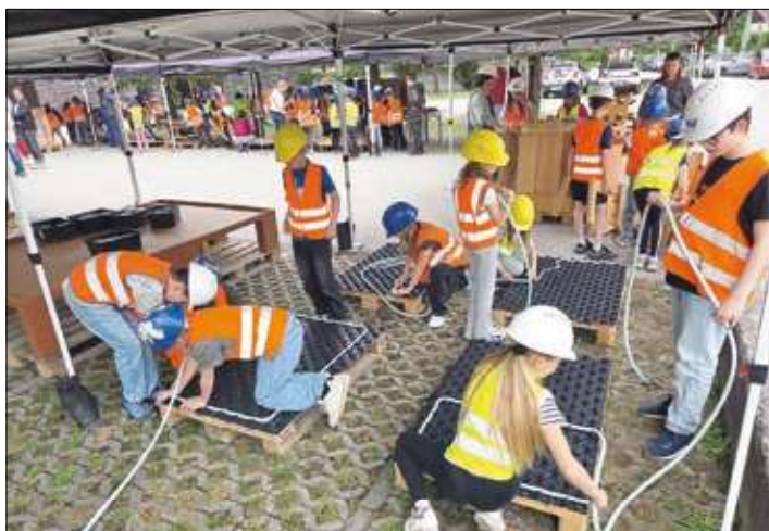
Eine Bodenheizung wird verlegt.
